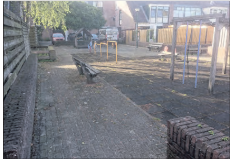
Het speeltuintje in Westbroek ondergaat dit jaar een grondige renovatie.
